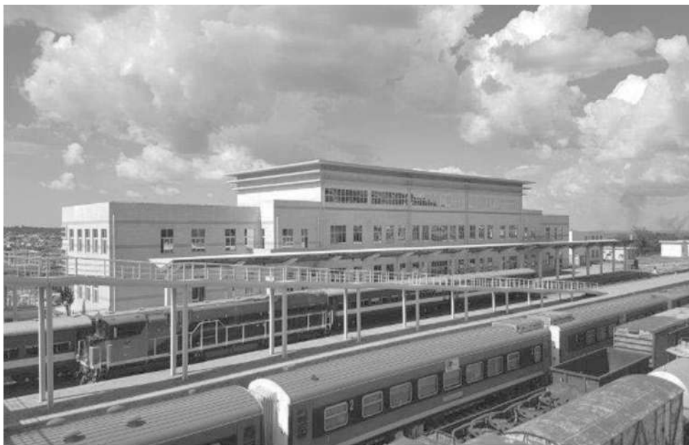
Figura 8-2: Estação do Lubango
