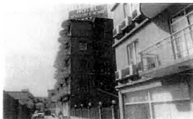
Figura 28: Hotel Horizonte Novo.
