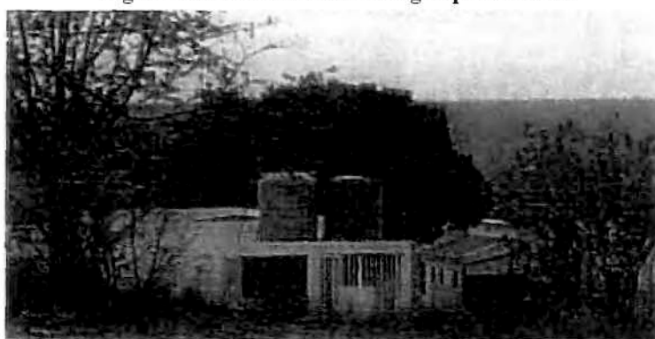
Figura 204: Reservatórios de água particulares
