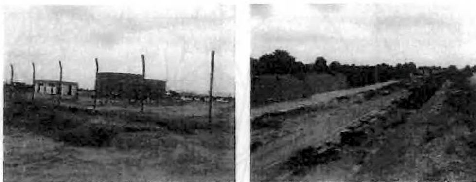
Figura 207: ETAR da ZEE Luanda-Bengo e respectiva vala de drenagem da água tratada.
