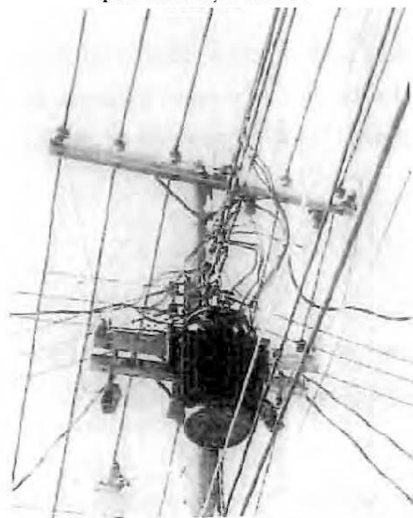
Figura 220: Poste com posto de transformação para distribuição eléctrica
