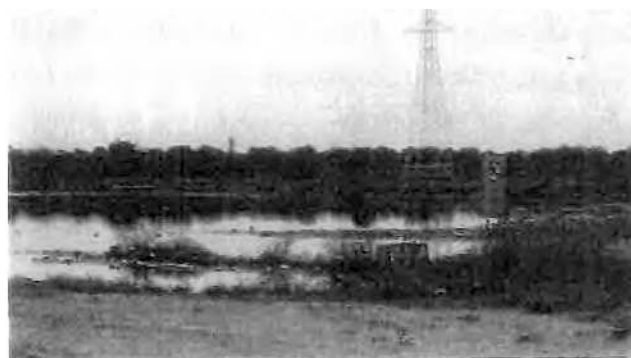
Figura 208: Lagoa proveniente de águas residuais tratadas da ZEB Luanda-Bengo
