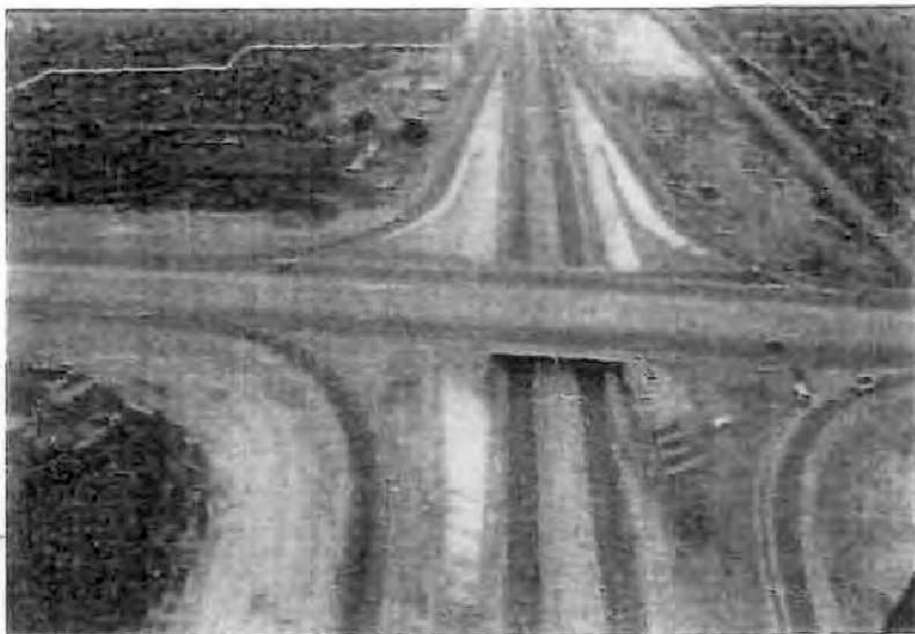
Figura 154: Nó de interseção da Via Expressa e da Estrada de Catete
