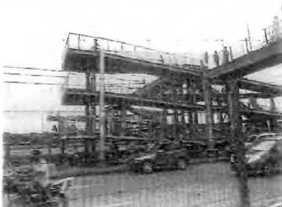
Figura 187: Passagem pedonal superior na estrada Viana-Catete.
