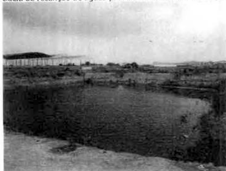
Figura 79: Bacia de retenção de águas provenientes dos colectores, bairro Km 9.
