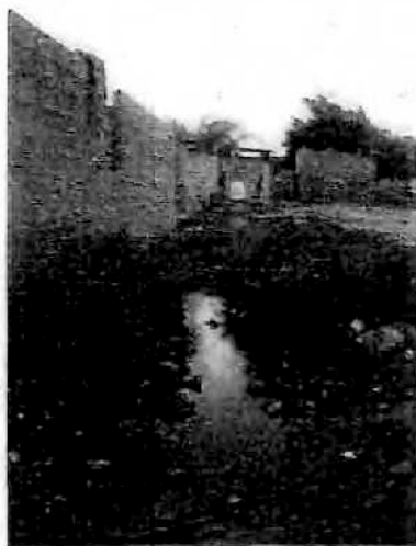
Figura 91: Obstrução e contaminação de linhas de água, Km 12 B Sector 9.
